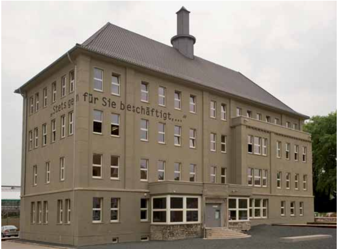
Das ehemalige Verwaltungsgebäude der Firma J. A. Topf & Söhne nach der Sanierung, 2011. Vor dem Gebäude befindet sich der Stein der Erinnerung .
