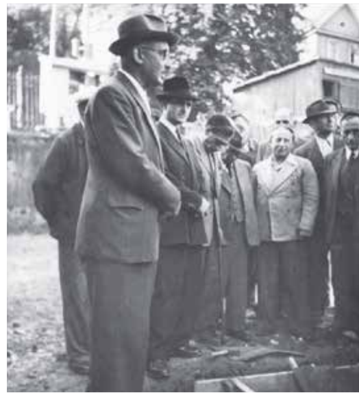
Grundsteinlegung für die Neue Synagoge mit Max Cars (vorne), 1951 © Nachlass Familie Cars, Jüdische Landesgemeinde Thüringen
