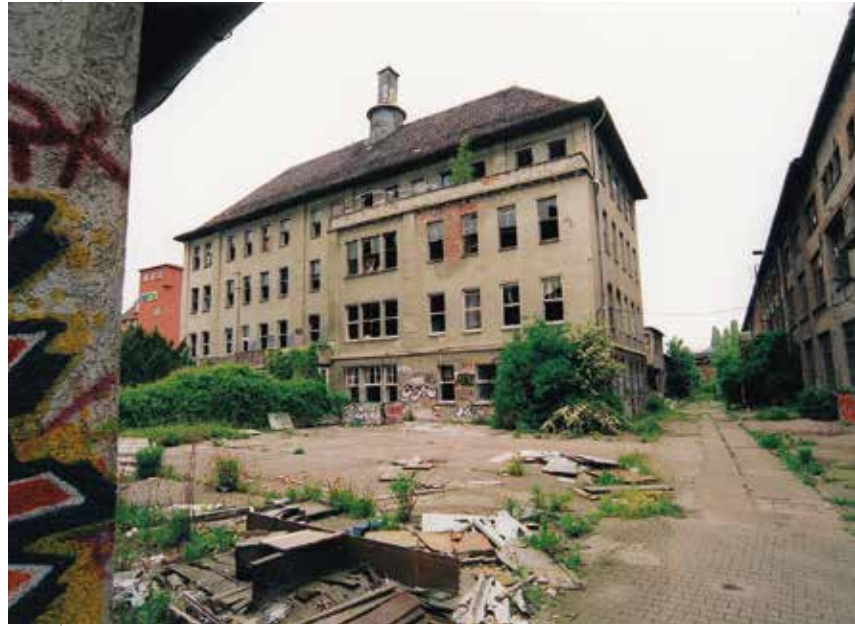
Ehemaliges Verwaltungsgebäude von J. A. Topf & Söhne vor der Umgestaltung zum Erinnerungsort
